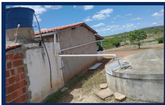
Figura 9 – Residências equipadas com caixas d'água suspensas sob a casa em Canudos.
