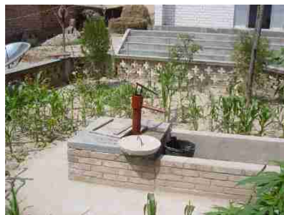
Cisterna com bomba no quintal de uma casa
