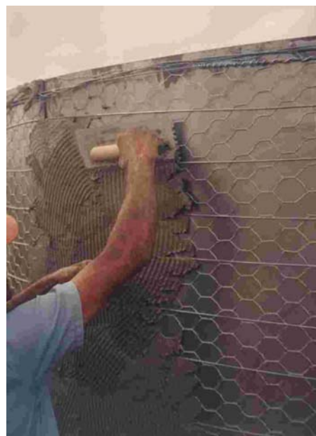
Ilustração 6: Colocação da primeira camada de argamassa acima da tela
