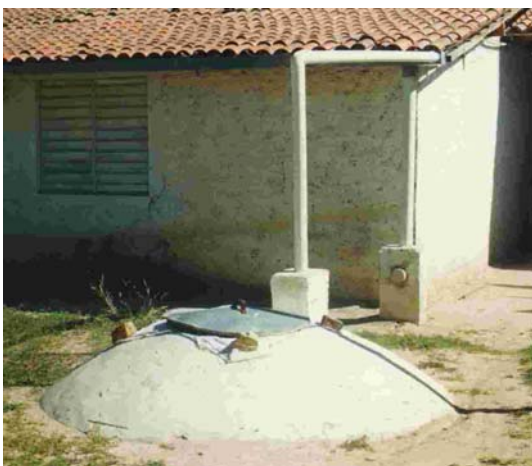
Ilustração 7: Cisterna de tijolos e argamassa de cal enterrada
