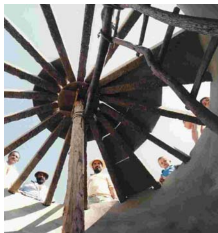
Ilustração 2: Armação da cobertura (visto por dentro da cisterna)
