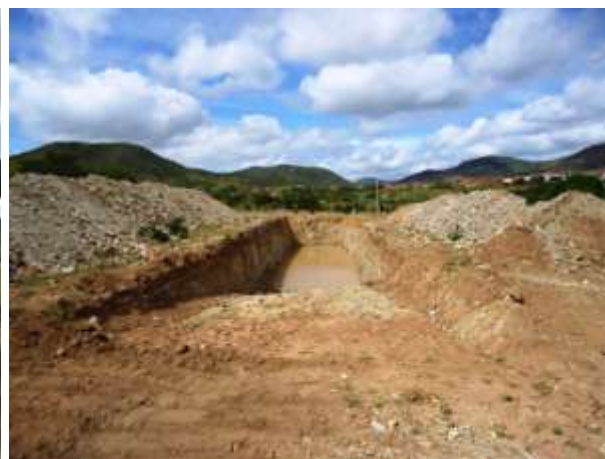
Fig. 2: Formato de barreiro trincheira
