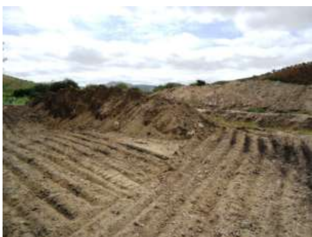
Fig. 3: Térrea retirada da lateral do barreiro
