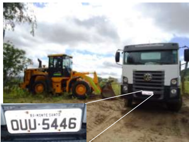
Fig. 1: Máquina e Caçamba usada na operação
