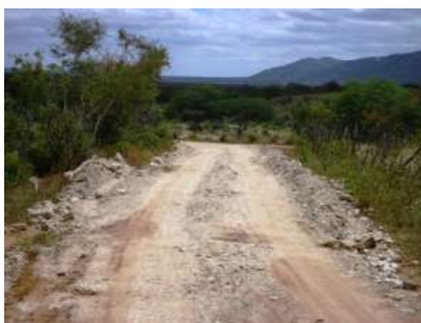
Fig. 4: Destino da terra retirada dos barreiros
