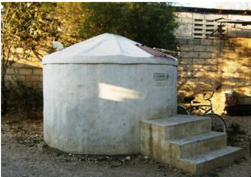
Uma das oito cisternas construídas pelo Brasil em Croix-des-Bouquets.
